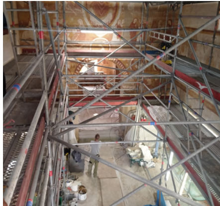
Saint-Martin de Vic - Nohant Vic (36) Travaux intérieurs - restauration des fresques ©ARC&SITES - Architectes Photo : CDC la Châtre Sainte-Sévère
