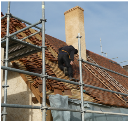
Saint-Martin de Vic - Nohant Vic (36) Travaux de toiture de la maison berrichonne ©ARC&SITES - Architectes
