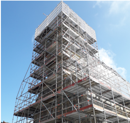
Saint-Martin de Vic - Nohant Vic (36) Travaux extérieurs : clocher de l'église ©ARC&SITES - Architectes Photo : CDC la Châtre Sainte-Sévère
