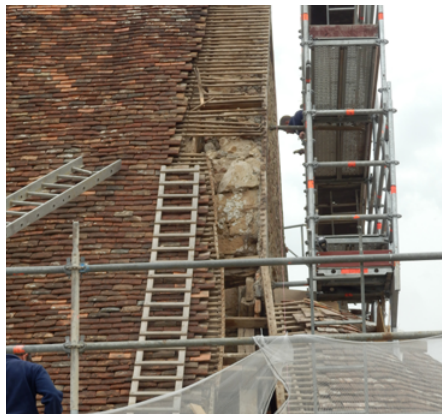
Saint-Martin de Vic - Nohant Vic (36) Travaux de la toiture de l'église ©ARC&SITES - Architectes
